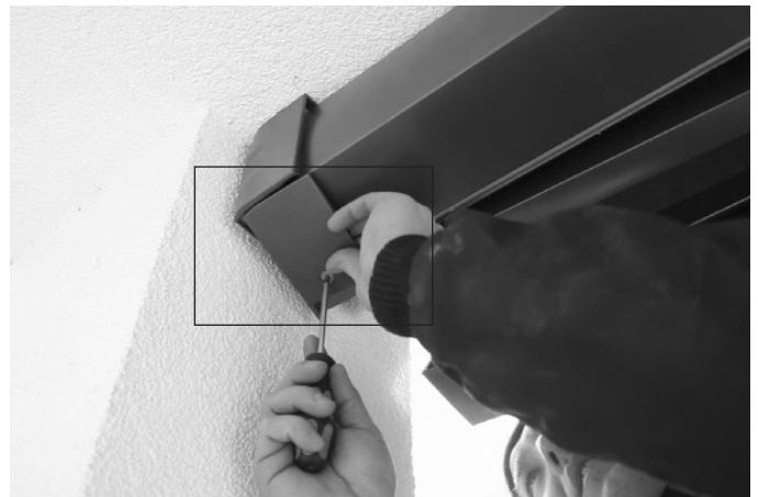
Abb. 12: Abdeckungen bei leicht geöffneter Markise anbringen
