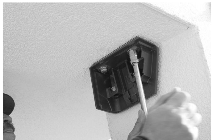
Abb. 08: Befestigungsschrauben anziehen (hier Bsp. Deckenmontage)
