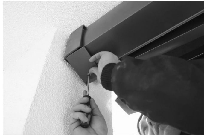
Abb. 16: Konsolen-Abdeckungen entfernen
