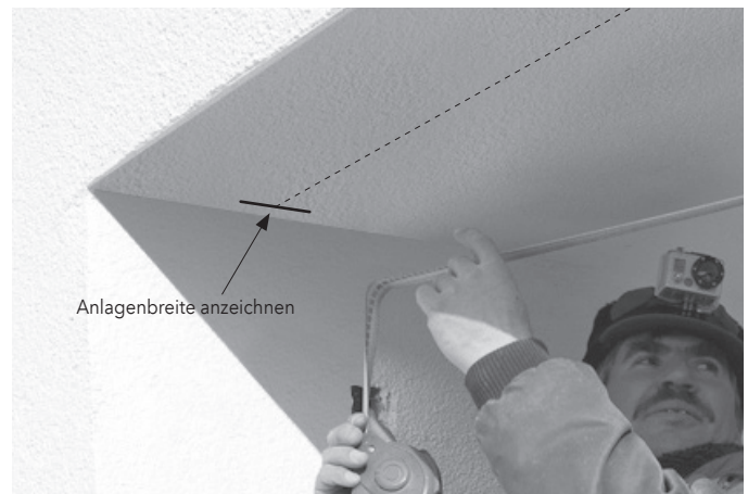
Abb. 03: Anlagenbreite anzeichnen (hier Bsp. Deckenmontage)
