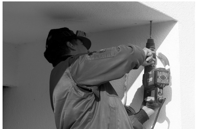
Abb. 06: Bohrungen setzen (hier Bsp. Deckenmontage)
