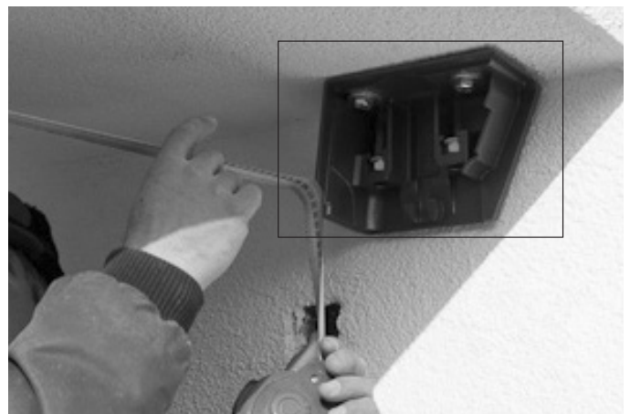
Abb. 07: Konsolen ausrichten (hier Bsp. Deckenmontage)
