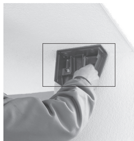
Abb. 05: Bohrbild übertragen (hier Bsp. Deckenmontage)
