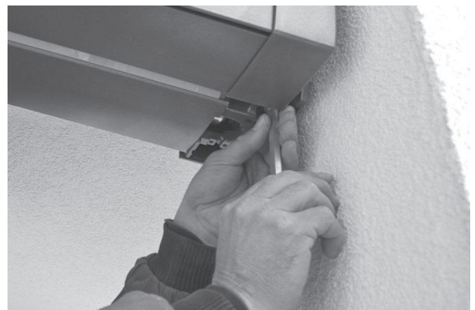
Abb. 11: Sicherungsschrauben setzen
