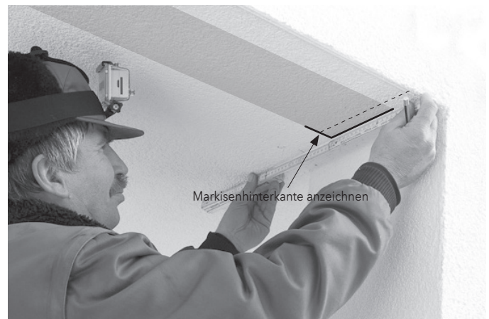
Abb. 04: Markisen-Hinterkante anzeichnen (hier Bsp. Deckenmontage)
